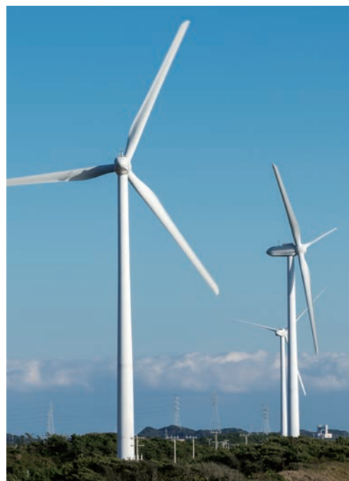
御前崎風力発電所（中部電力株式会社）
