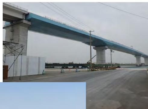
新町川橋 (徳島県 / 国土交通省 四国地方整備局)
