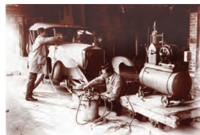
昭和初期には合成樹脂塗料の開発が進み、自動車への塗装実験も重ねられました。
