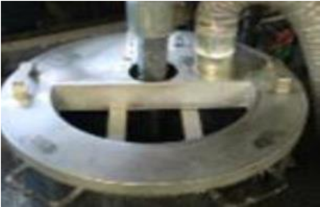
タンク上部に柵をする
