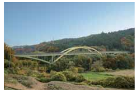
第17回 里美大橋 〈茨城県常陸太田市/公共施設〉 改修部門
