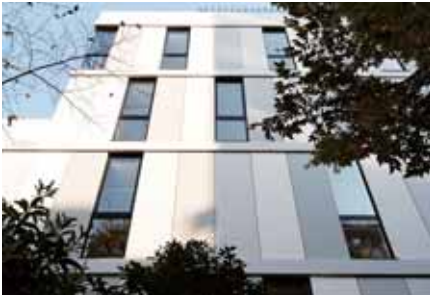
第13回 南江堂第二ビル 〈東京都文京区/企業施設〉 新築部門
